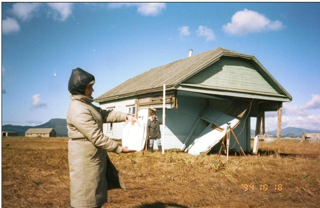
Рисунок 1.18 – Дом, сорванный цунами с фундамента и перенесенный на расстояние около половины километра по долине реки Серебрянка.
